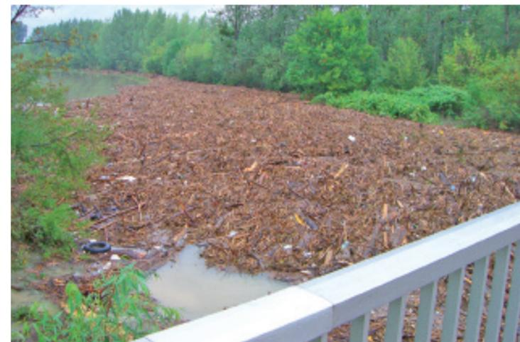
Unmengen von Holz haben sich an der Zainethbrücke in Mannswörth gestaut. Aufgrund der geringen Fließgeschwindigkeit bestand jedoch keine Gefahr für das Bauwerk.
